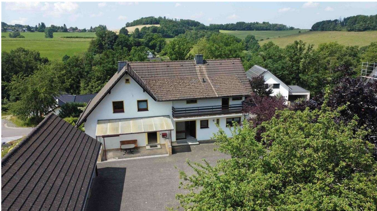
Rückseite: jedes Haus mit eigenem Eingang/Terrasse
