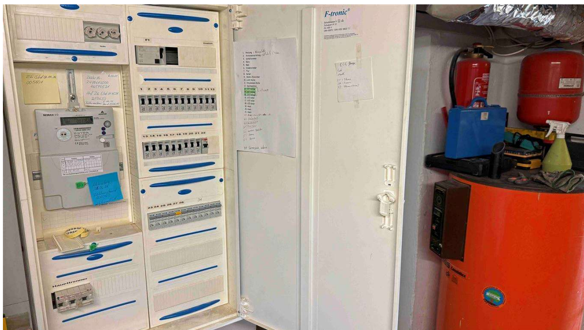
Elektrik modernisiert und für beide Häuser getrennt
