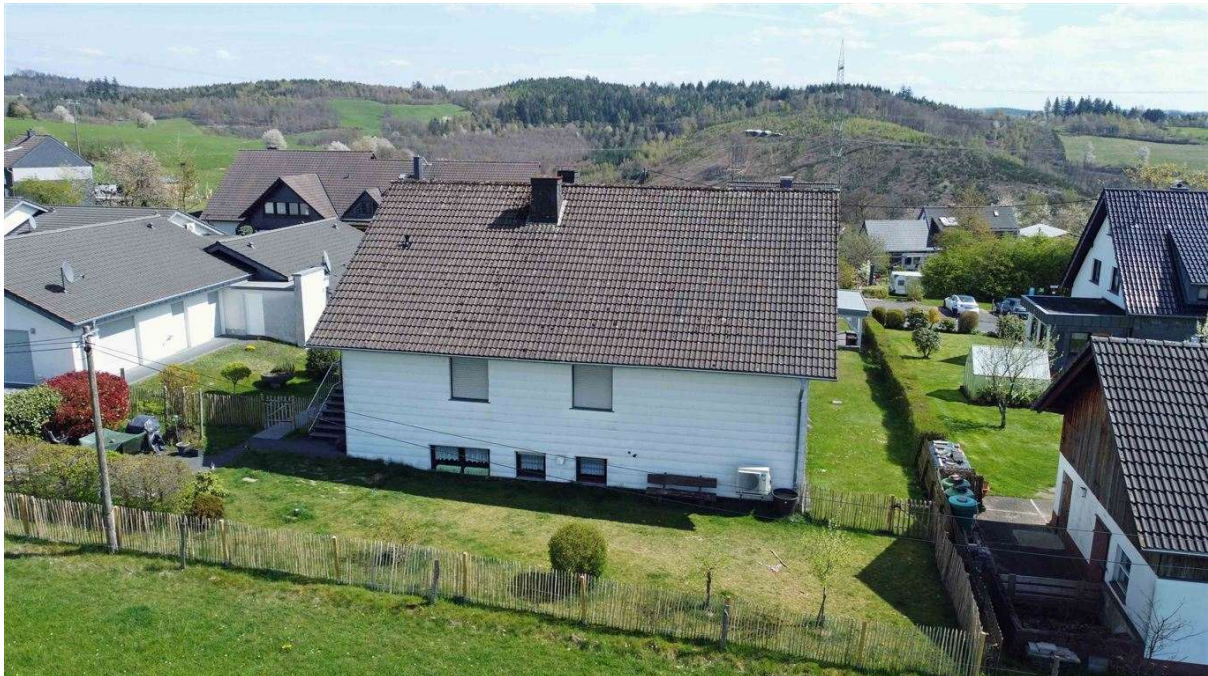
Hausrückseite, Fassade an den Wetterseiten gedämmt
