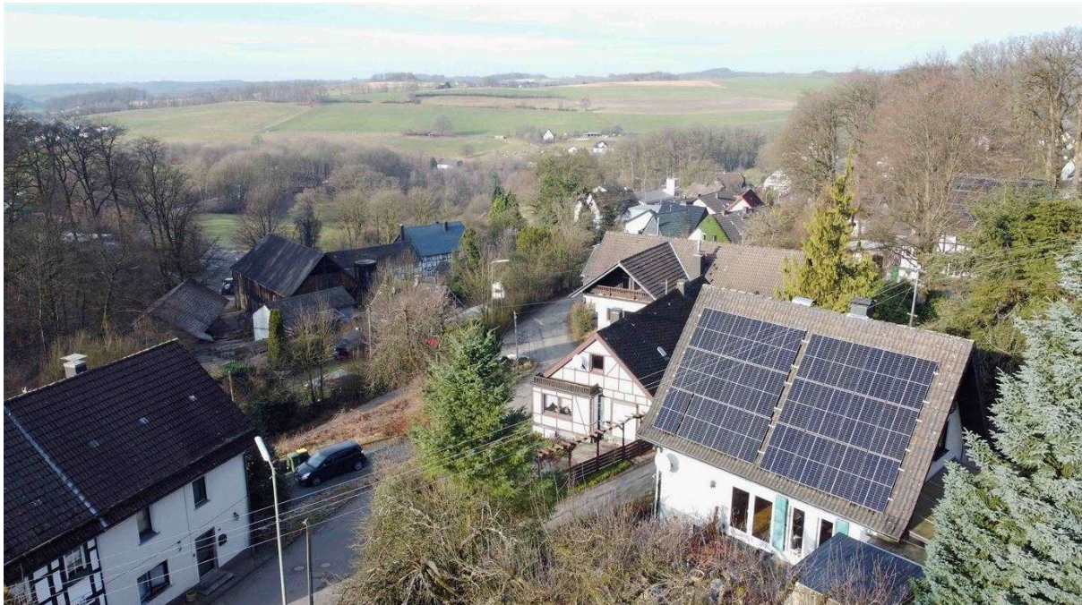
Höhenlage mit Fernblick. Große PV-Anlage, Baujahr 2022
