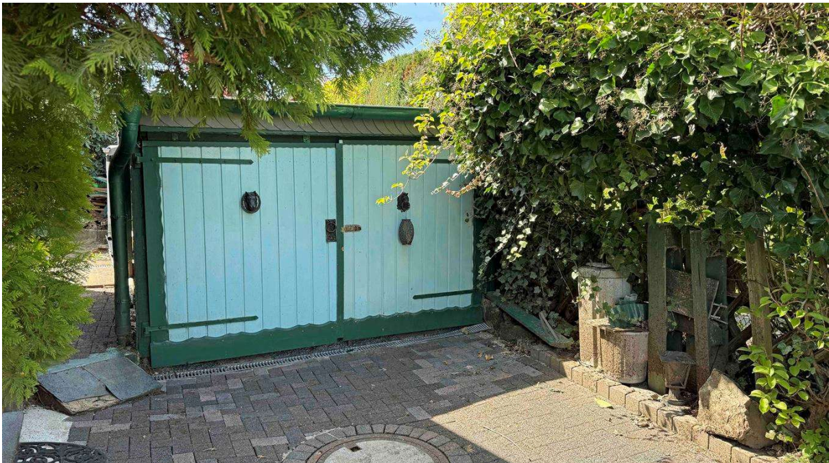
...dahinter: Garage mit Wallbox
