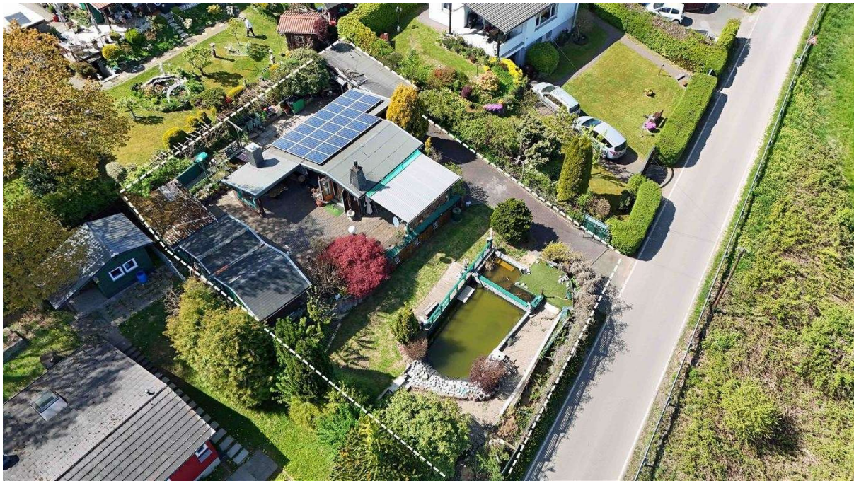
Die PV-Anlage auf dem Dach...
