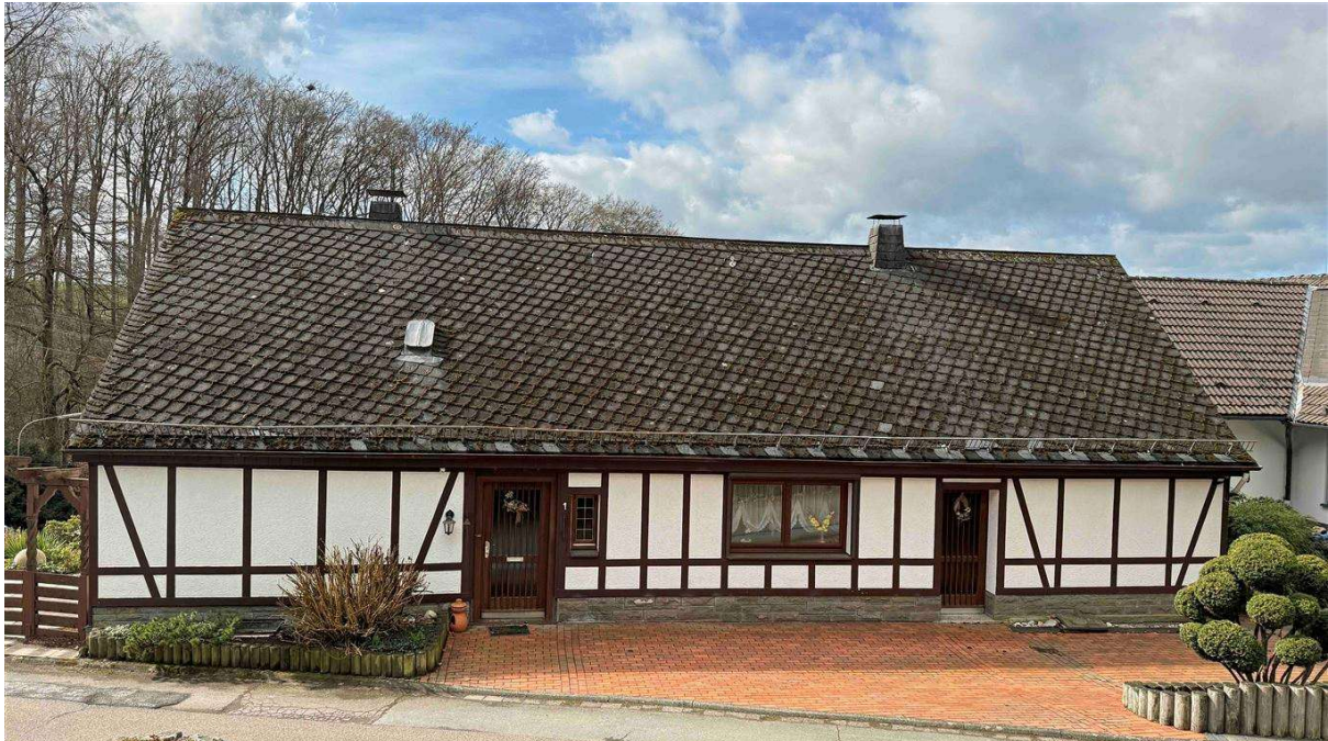
Frontansicht, parken direkt vor der Haustür möglich
