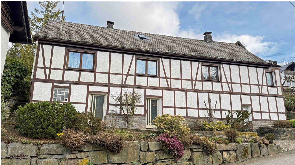
Hausrückseite. Fassade wurde 1996 komplett gedämmt!
