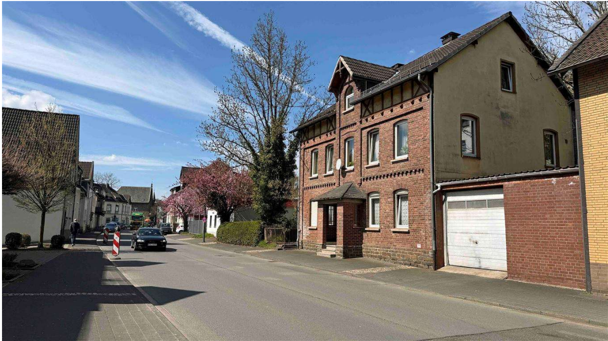
Ansicht Ostgiebel, zur Ortsmitte von Morsbach
